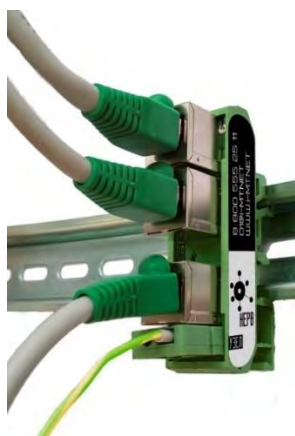
Рисунок 8.1 – Монтаж узла Нерв
